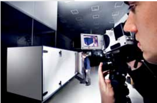
Тепловой снимок установки
