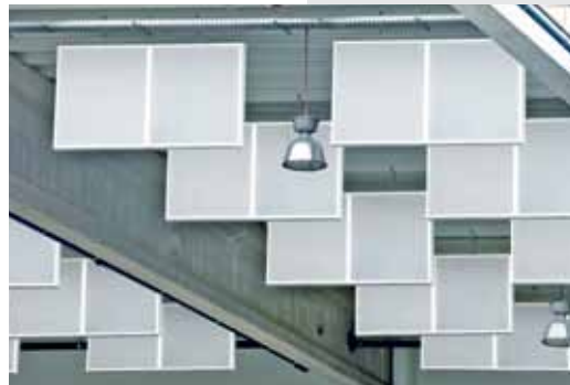
Оптимизированная акустика на заводе благодаря шумоглушителям TROX
