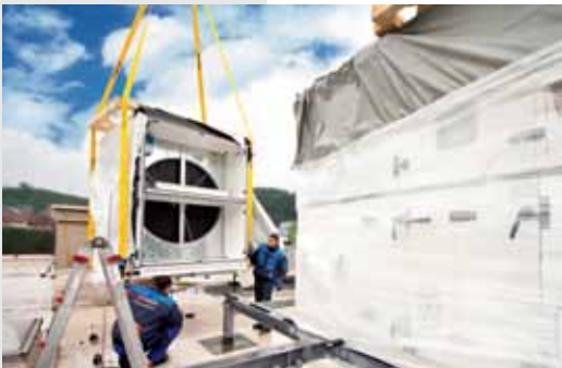
Доставка и монтаж установки в погодозащищенном исполнении
