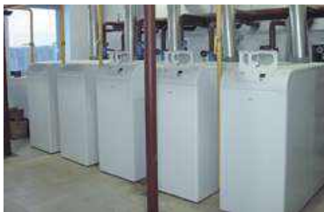
Кинотеатр, г. Йошка-Ола Общая мощность - 1,6 МВт
